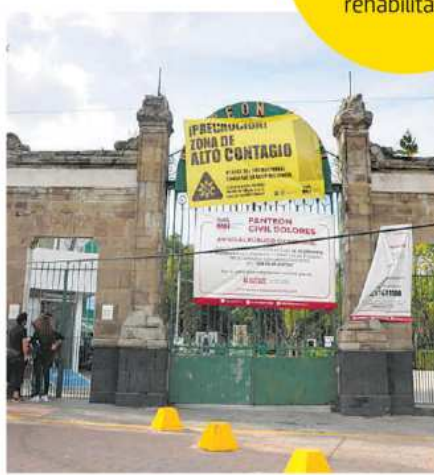
Se demolerá la barda perimetral del Panteón de Dolores por su mal estado
