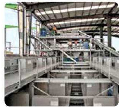
OBRA. La Estación de Transferencia y Planta de Selección recibirá residuos de vidrio, PET, plástico, papel y cartón. La planta estará lista este mes de diciembre.
