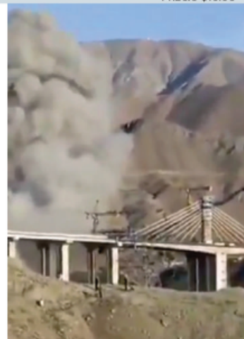
DERRUMBE del puente más alto de Irán.
